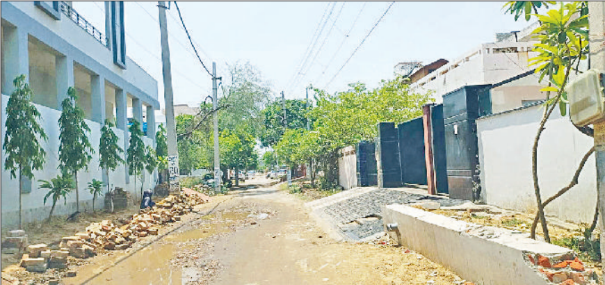
भिवानी। निर्माण के लिए तोड़ी गई जर्जर सड़क का दृश्य।
